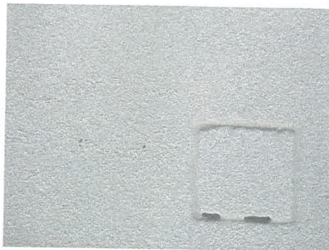
Рисунок 4 –Вигляд опоряджувального шару фрагменту дослідного зразка № 89-2/21 після випробування
