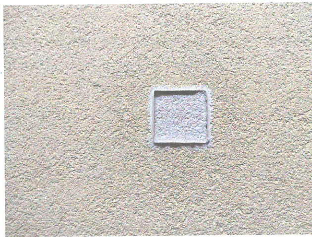
Рисунок 2 – Зовнішній вигляд дослідного фрагменту системи зовнішньої теплоізоляції Caratect Standard після циклічних впливів
